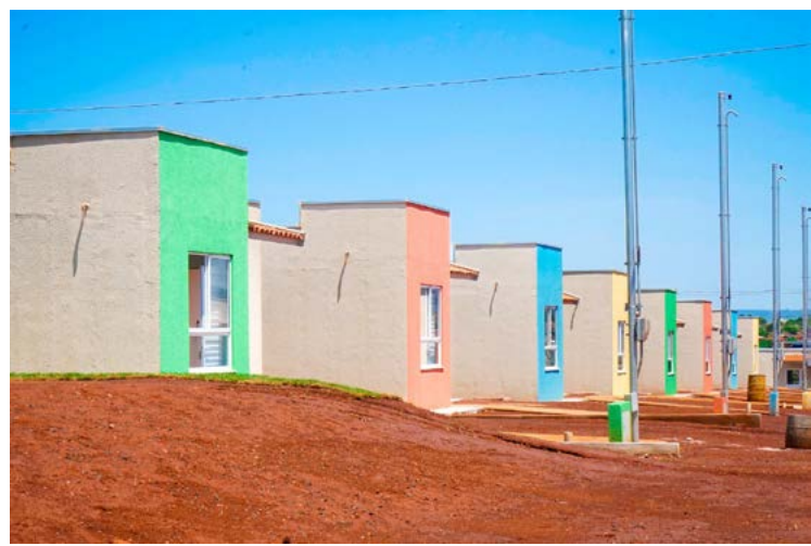
Programa Pra Ter Onde Morar em Quirinópolis: o prefeito Anderson de Paula, projeta iniciar a construção de mais 100 casas em abril de 2024 — Imagem: Reprodução.
